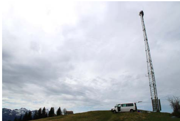
Abbildung 3: Installation des Gaseinlasses an der Turmspitze am Gäbris. Das Technikgebäude schliesst sich am rechten, unteren Rand des Bildes an.
